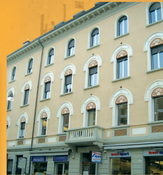
Ristrutturazione in Corso Mazzini a Forlì
